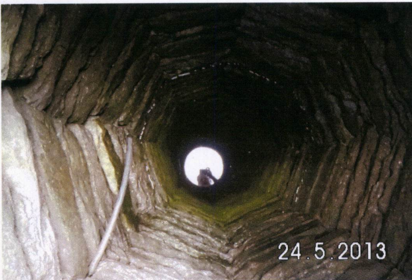
Resim3: , Ovapınar Köyü Boğagediği Mahallesinde bulunan Kuyunun iç kısmı düzgün yassı uzun taşlarla örülmüş ve sekizgen bir forma sahiptir.
