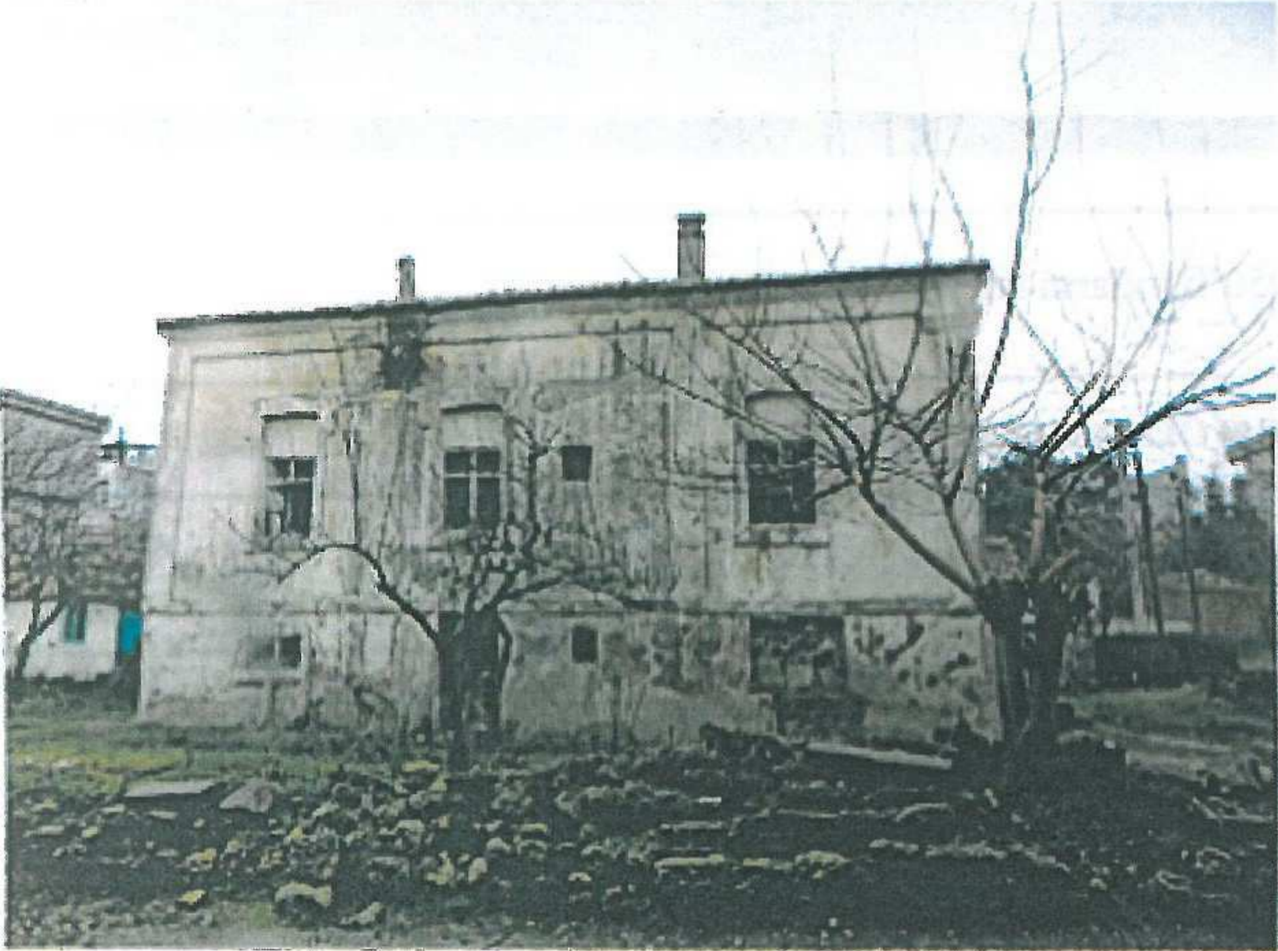
Sol yan cephe
