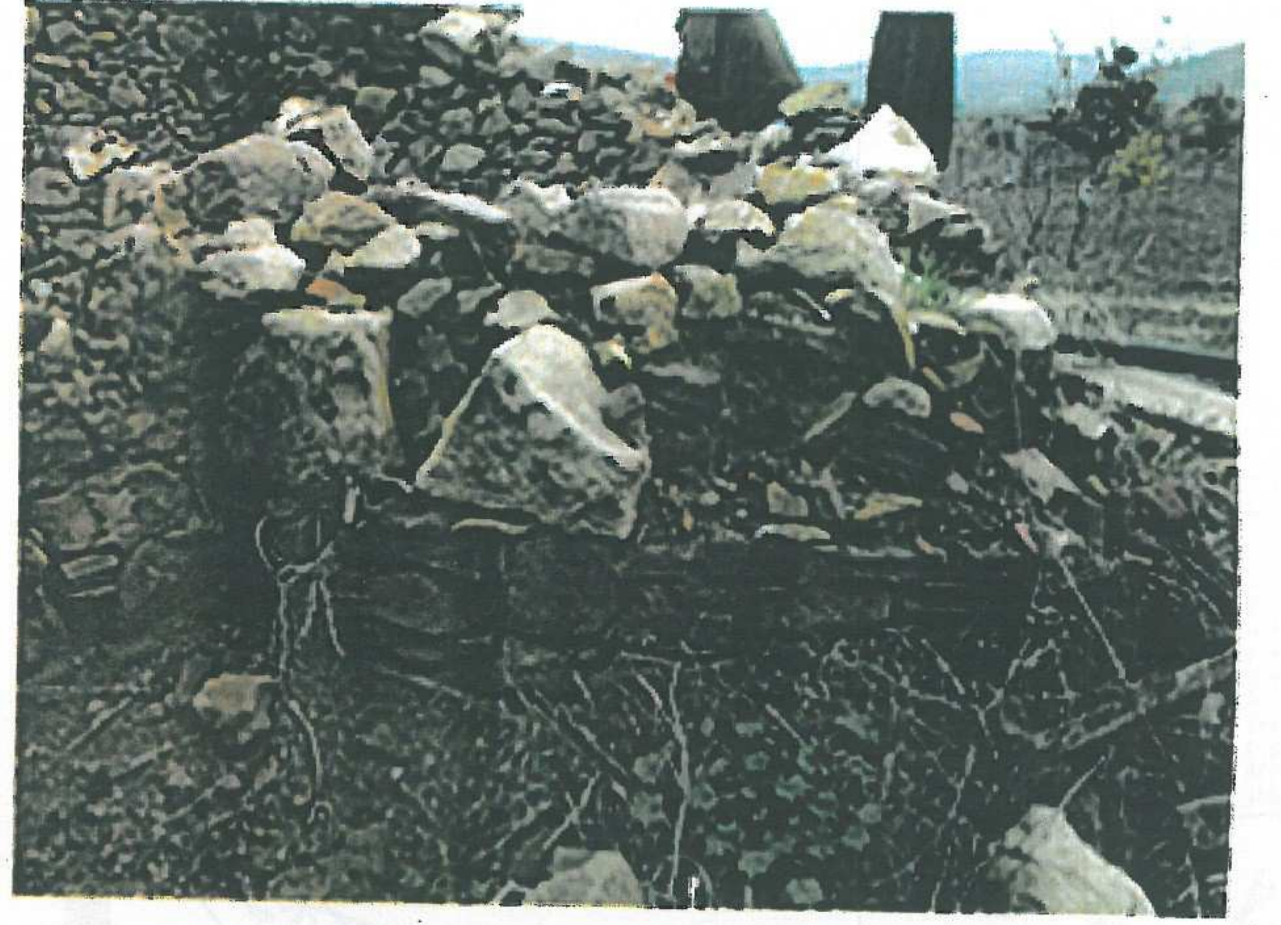
Sağ Yan Cephe Duvarındaki Ocak
