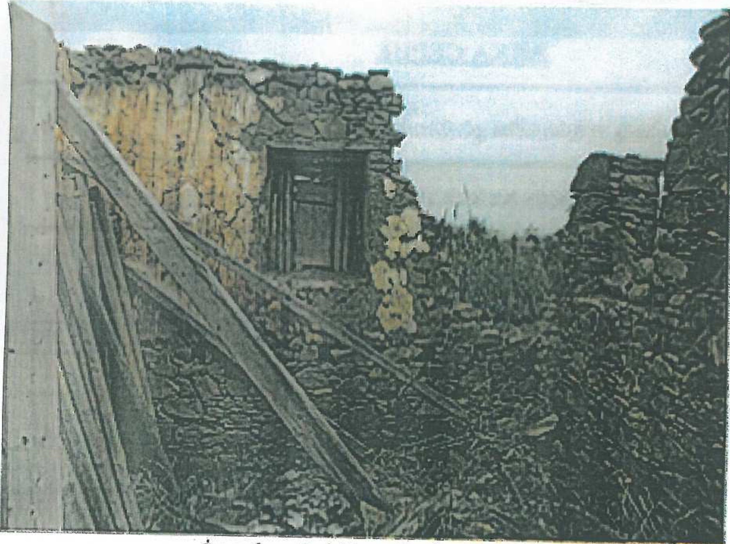
İçerden Sol Yan Cephe Duvarı
