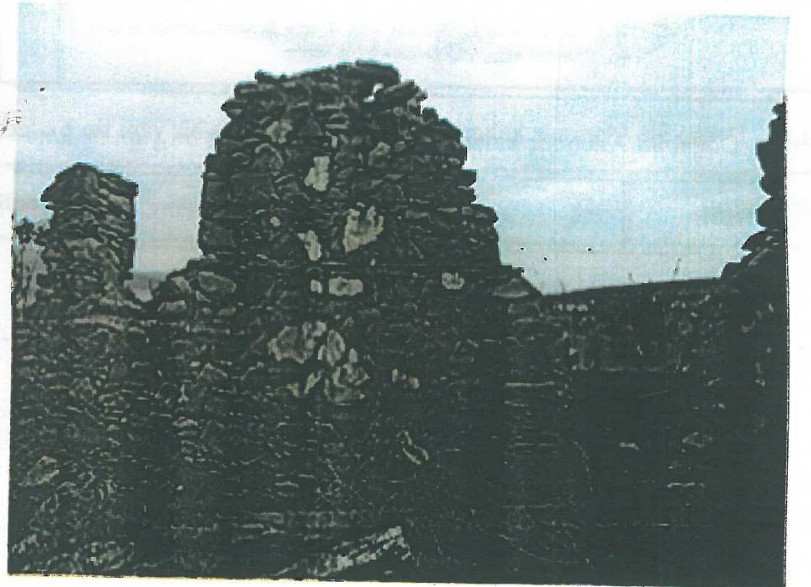
İçerden Arka cephe Duvarı
