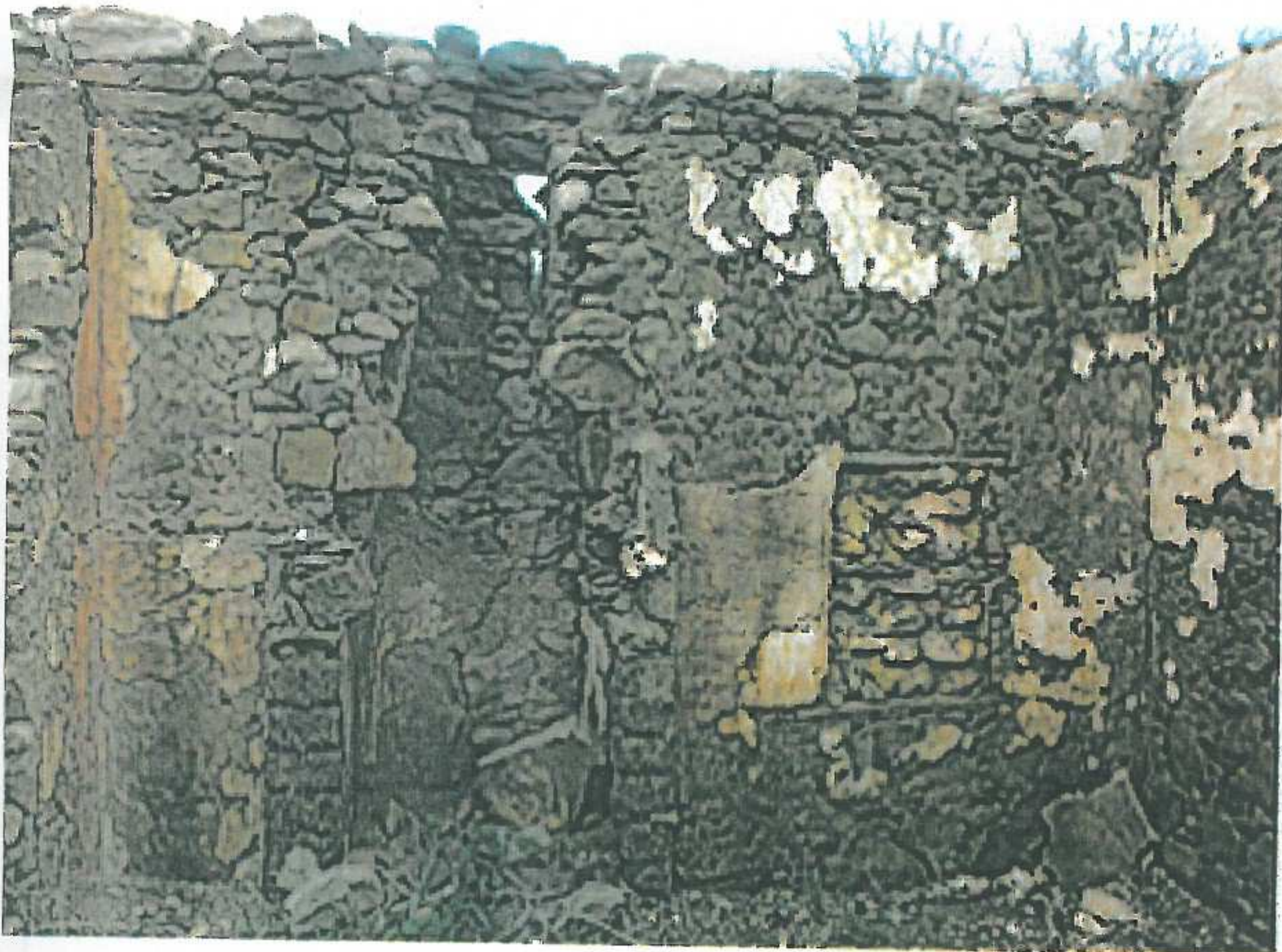
İçerden Ana Mekan Sağ Yan Cephe Duvarı
