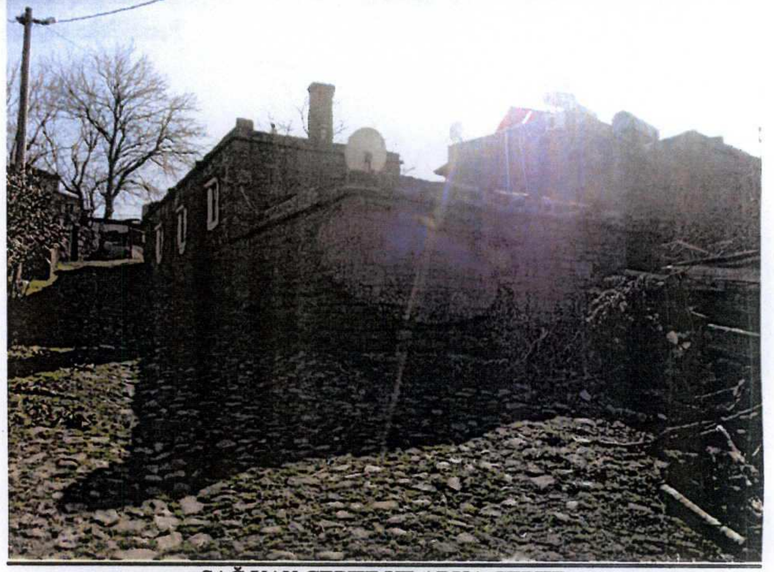
SAĞ YAN CEPHE VE ARKA CEPHE
