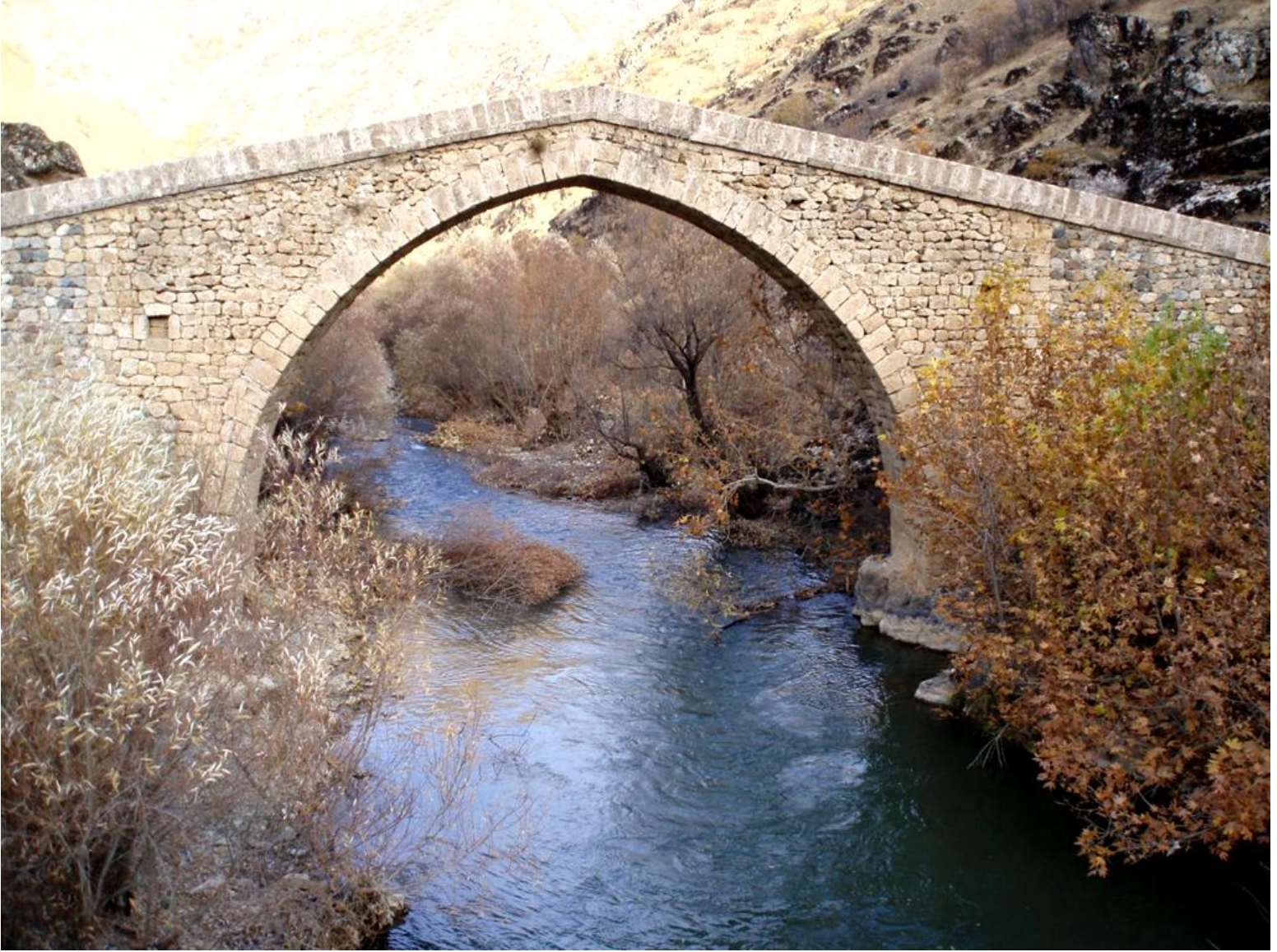
NEHRİ TAŞ KÖPRÜ
