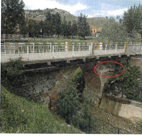
Debbay Köprüsü'nün mansap tarafındaki beden Duvarında yer alan heykellerin görünümü.
