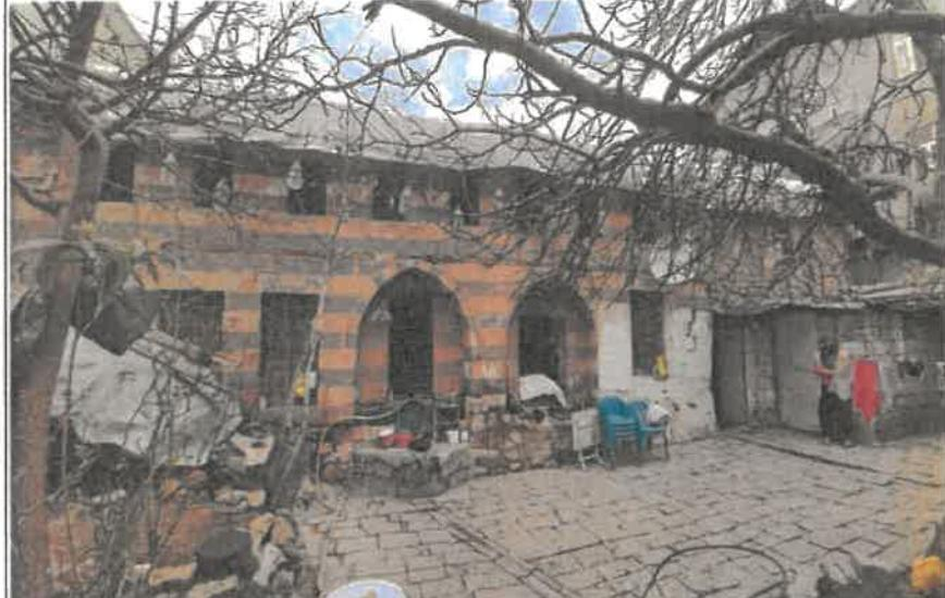
**GÖZLEMLER:** Yapı avlu duvarı ve özgün taç kapı arasında ayrilmalar ve avlu duvarının bir bölümünde yıkılma olduğu görülmüştür. İbadet mekânının güneydoğu köşesinde duvar orgüsünde ayrilmalar olduğu tespit edilmiştir. İbadet mekâni taşıyıcı sütun ve kemerlerde ciddi çatlaklar bulunmaktadır. Toprak dam olan üst örtüyü taşıyan ahşap kirişlerin sehim yaptığı, üst örtünün bazı bazi noktalarında çökme olduğu görülmüştür.
